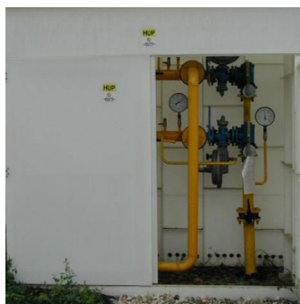
Obrázek 8 – Odběrné místo ZP v areálu Nemocnice
