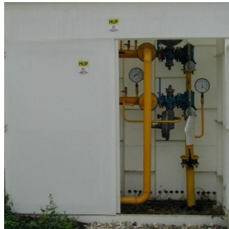
Obrázek 15 – Odběrné místo ZP v areálu Nemocnice
